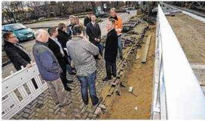
Beim Ortstermin am Haltepunkt der Wurmthalbahn gegenüber dem Kreishaus bekamen die Teilnehmer der FDP-Infoveranstaltung einen Eindruck vom Fortgang der Bauarbeiten. Fotos (2): defl
